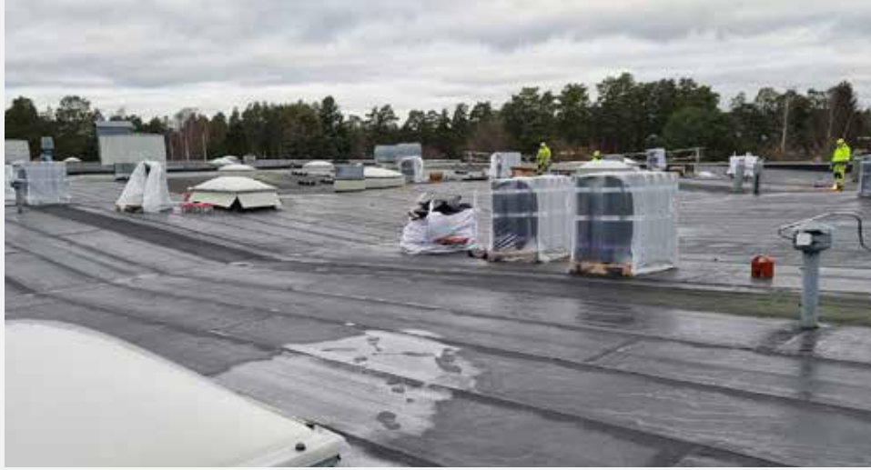
Viimeisin osa kiinteistömme kattopinnoista sai uuden pinnoitteen, uudet sadevesiviemärit ja kattoikkunat.
