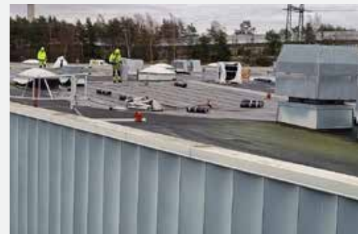
Myös kattoikkunoiden sekä katon reunojen pellitykset uusittiin.
