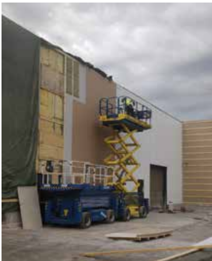
Palo-osastoinnin lisätyöt aiheuttivat noin kolmen viikon viivästymisen.
